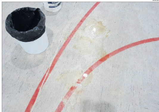
El pavelló de Sant Julià de Lòria ha quedat força malmès per les goteres.
